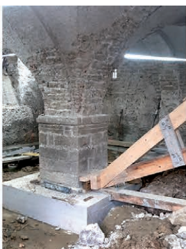
Suite des travaux au caveau du presbytère avec le renforcement des fondations des piliers
