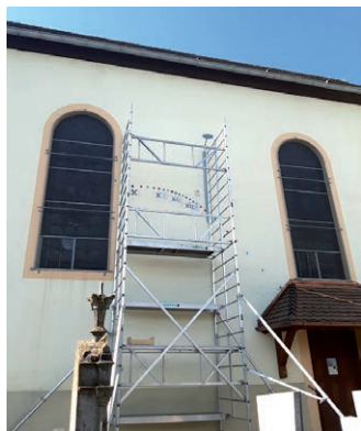
21 juin : Travaux préparatoires du nouveau cadran solaire à l'église
